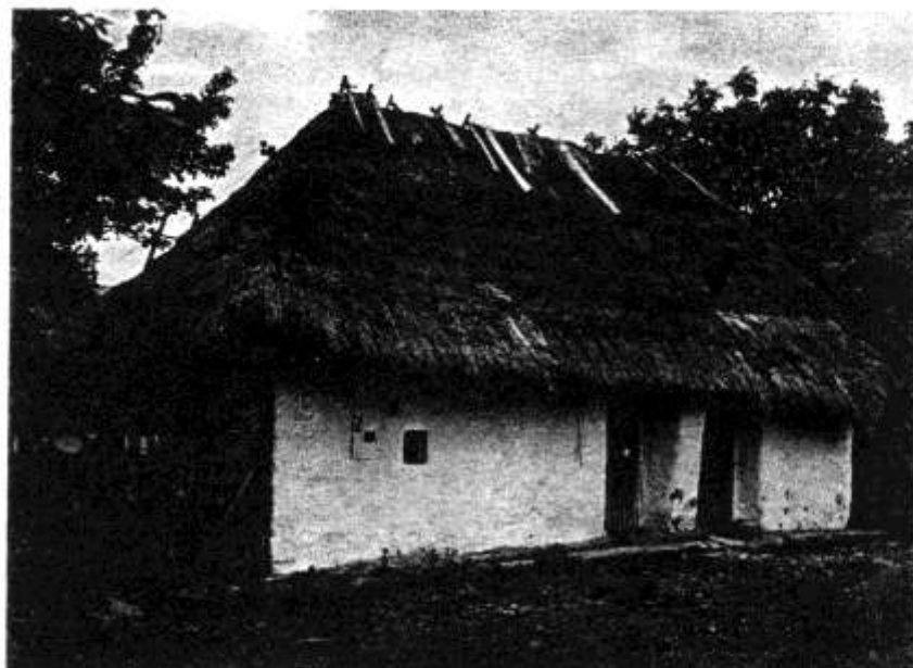
Obytná časť laznickej usadlosti Fišerovcov v lazoch. Hrušov. Foto T. Szabó 1980
