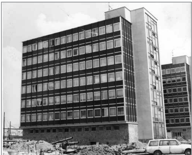
Výstavba bytových domov Jadran 70. roky 20. storočia – sídlisko Etapa
